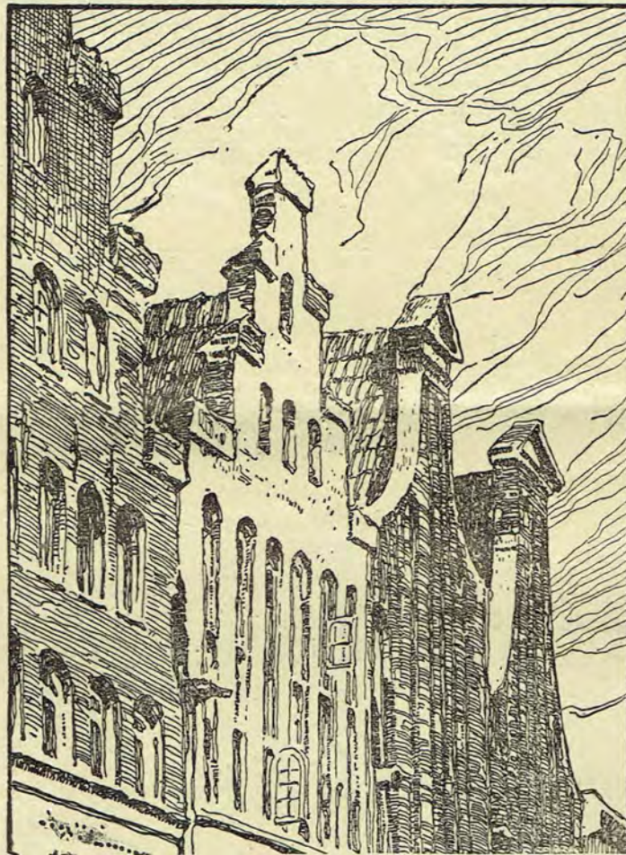
Charakteristische Giebelhäuser aus der Lübecker Altstadt
