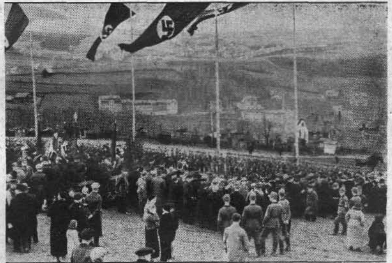
Spatenstich für 198 Siedlungen.
