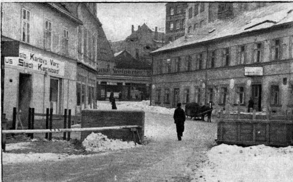
Auf Grund des Staatsvertheidigungsgesetzes läßt die tschechoslowakische Regierung, wie wir im T. A. W. melden, längs der Grenze gegen Deutschland bei Zollstraßen Sperrmauern errichten. In Weipert wurden links und rechts der Grenzbrücke Betonblöcke gestellt, so daß künftig Kraftwagen und Geschirre ganz langsam fahren müssen. Der Gehsteig auf der linken Seite der Straße, der vor dem Gasthaus „Stadt Karlsbad“ vorbeiführt, wurde mit Eilenraverseilen verriegelt. (T. A. W.-Bilderdienst.)
