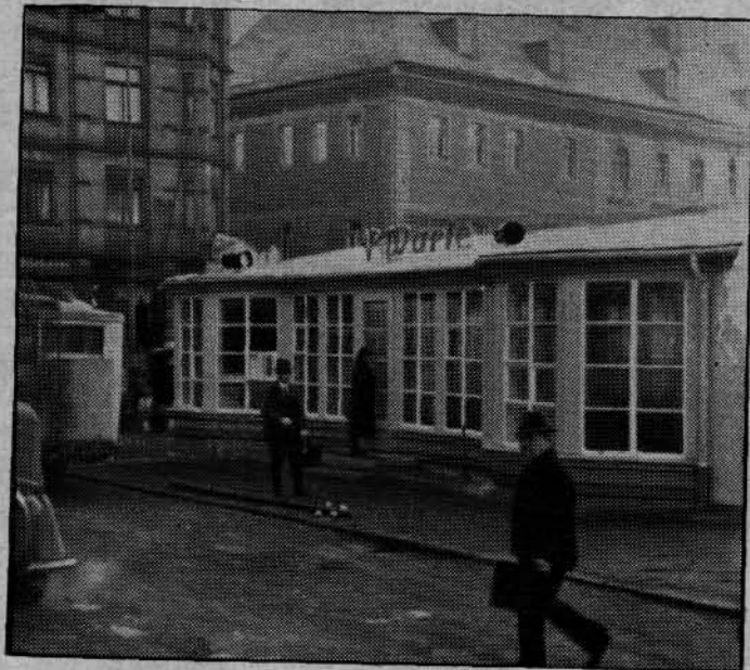
Das neue Verkehrshäuschen.
