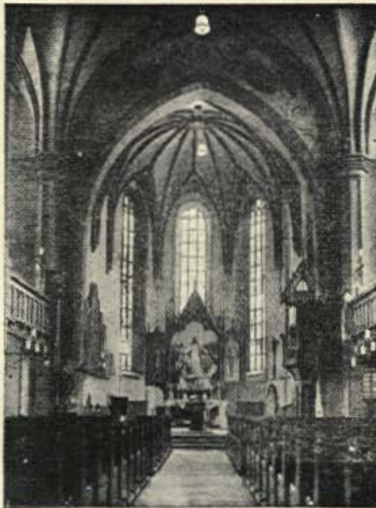
Die Innenansicht der St. Katharinenkirche vor der Erneuerung.
