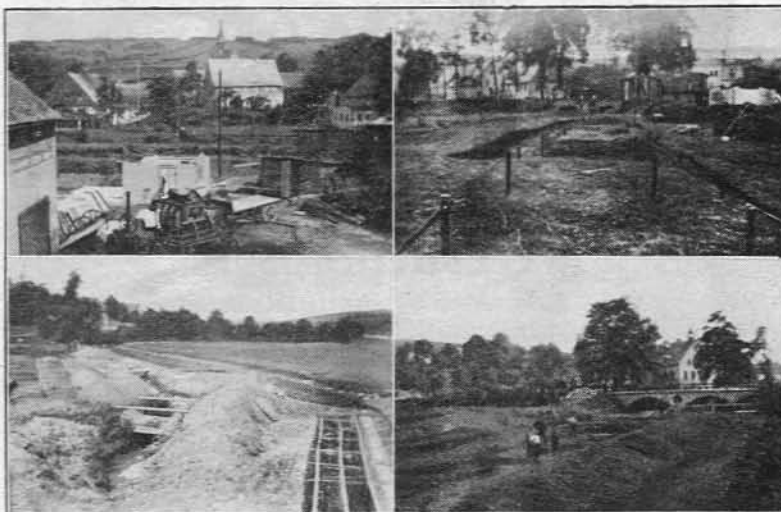
Oben rechts: Böhlaregulierung im Mittel von Königswalde; oben links: Geräte- u. Maschinenpark der die Böhlaregulierung ausführenden Firma; unten rechts und links: Böhlaregulierung am unteren Bahnhof in Königswalde.
