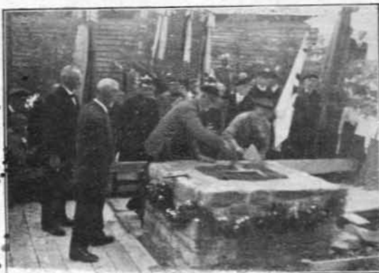
Die Zumauerung des Steines.
