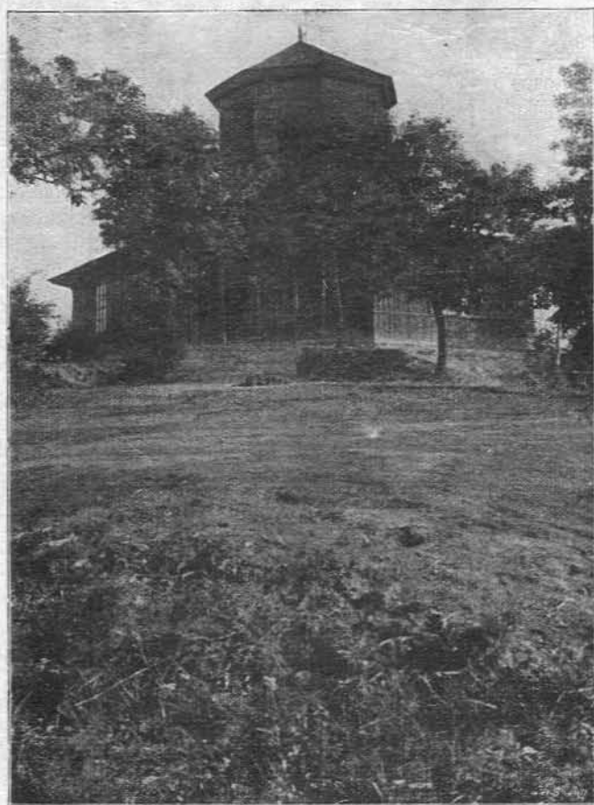
Die ehemalige Hutberg-Gloriette bei Komotau (510 m).
