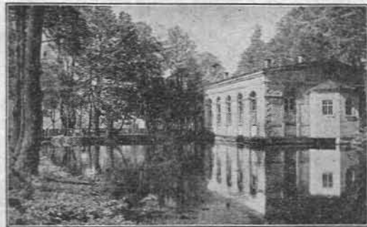
Parkmotto mit Saalgebäude Arnoldshammer
