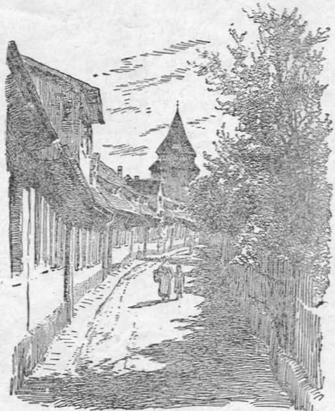
Eine Partie der Grabenhäuschen, die größtenteils noch um die Altstadt herum gehen, hier der Seelengraben
